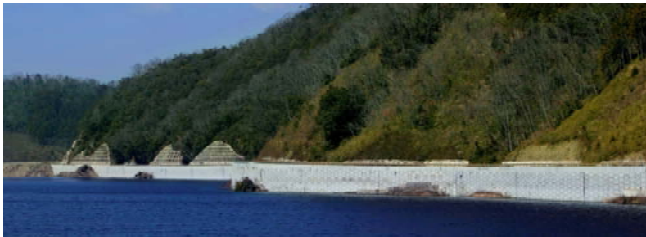
於 山梨県市町村研修所(自治会館) 平成24年11月1日 多数アンカー式補強土壁協会
