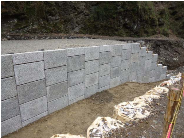
写真-1 施工状況①
