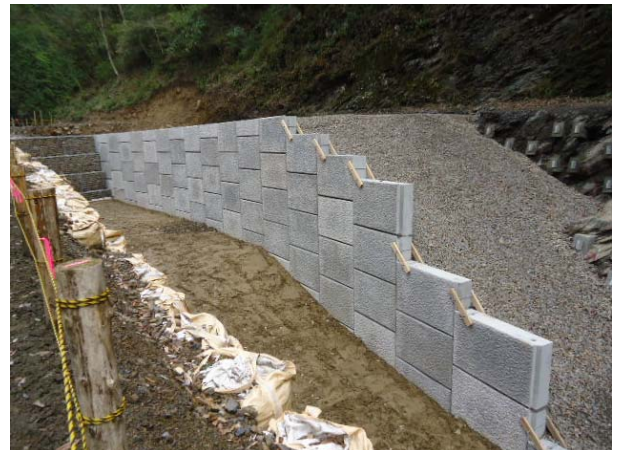
写真-2 施工状況②
