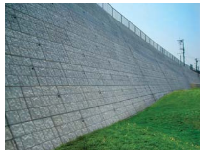
斜壁多数アンカー式補強土壁
