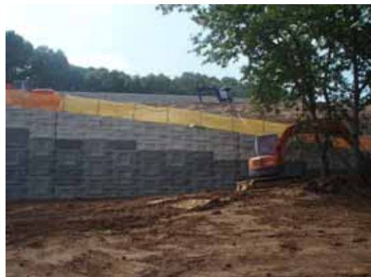
図6 補強土壁完成状況
