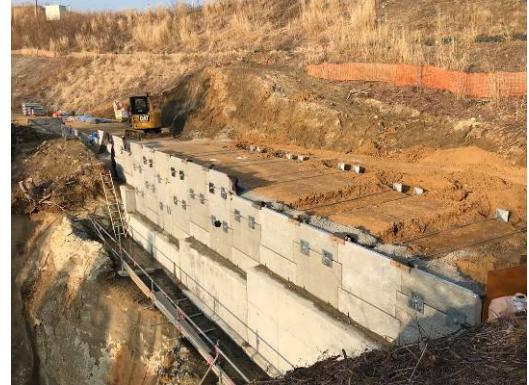
写真1 実験対象区間全景
