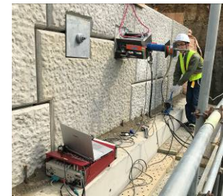
写真4 リフトオフ試験の状況
