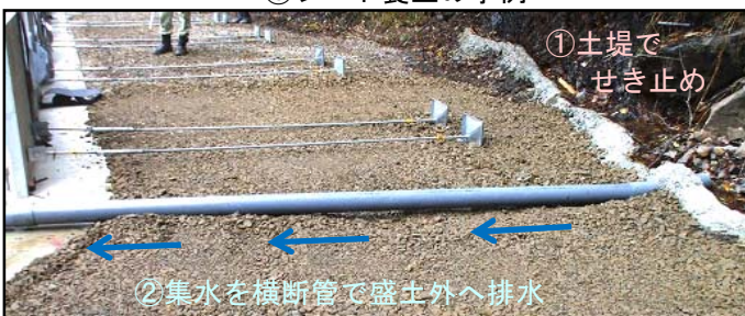
③土堤と横断管による事例
