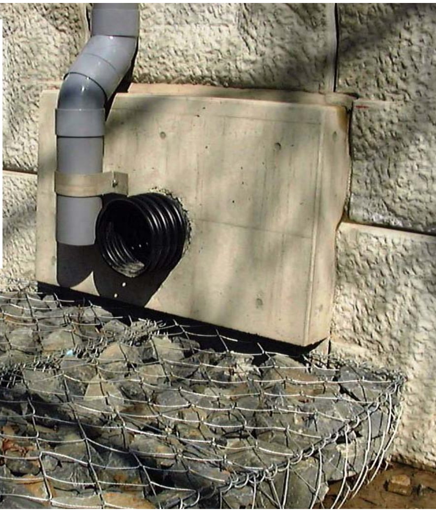
事例4： 排水管の振れ止め1
