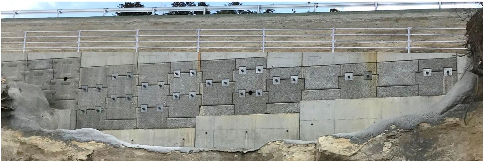
ロッドを壁面から突出させた構造の連結部を有するアンカー補強土壁
