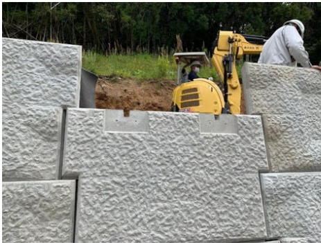
① 下側壁面材の設置
