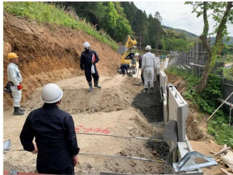
② 診断用補強材設置位置の撒き出し、敷均し、締固め
