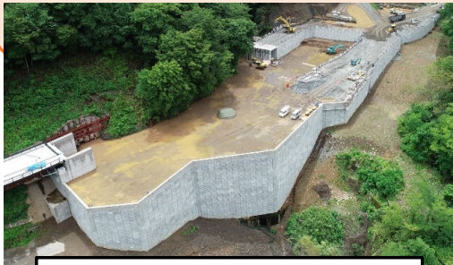
UAVによる点検の適用事例
