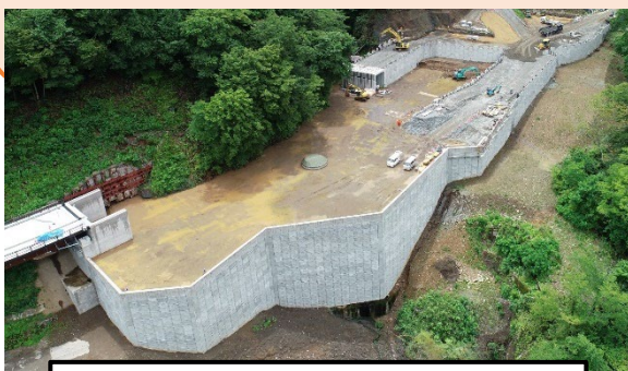
UAVによる点検の適用事例
