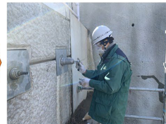
（施工後）頭部キャップ取付け （防錆剤を含む）
