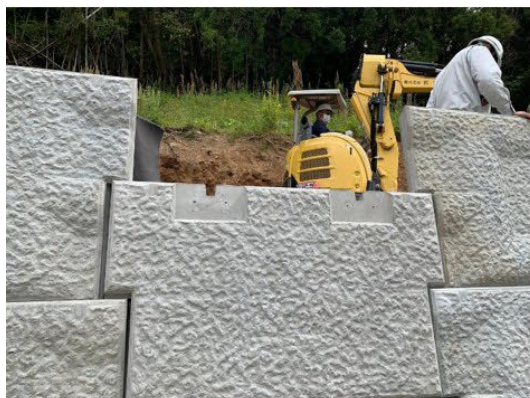
① 下側壁面材の設置
