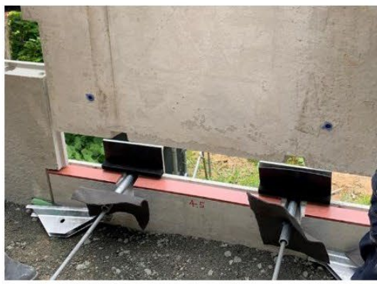
⑦ 上側壁面材の設置、固定 ⑧ 撤き出し、敷均し、締固め
