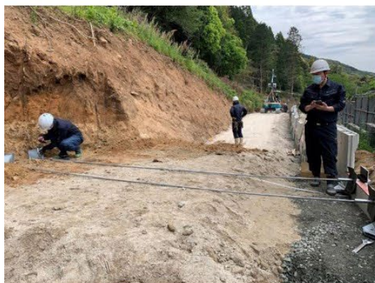
⑥ アンカープレート、コネクター、シール材の取付け
