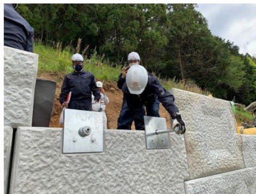
③ 支圧板類を壁面材前面に取付け ④ トルク鋼管類を支圧板に取付け
