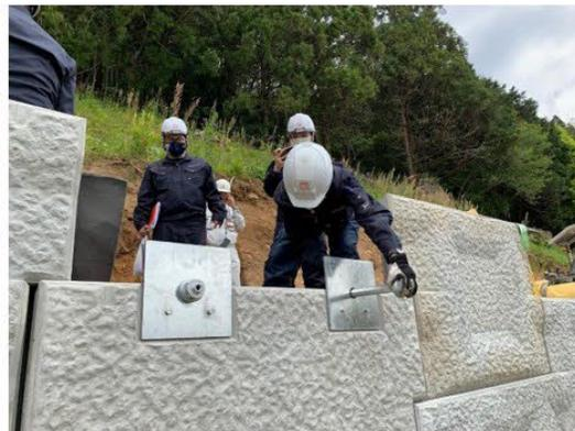
③ 支圧板類を壁面材前面に取付け
