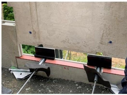
⑦ 上側壁面材の設置、固定
