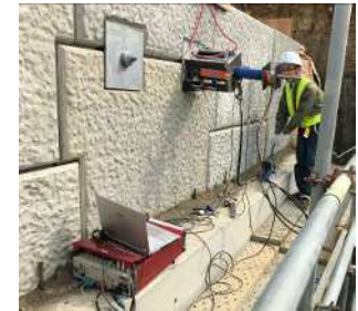
写真4 リフトオフ試験の状況
