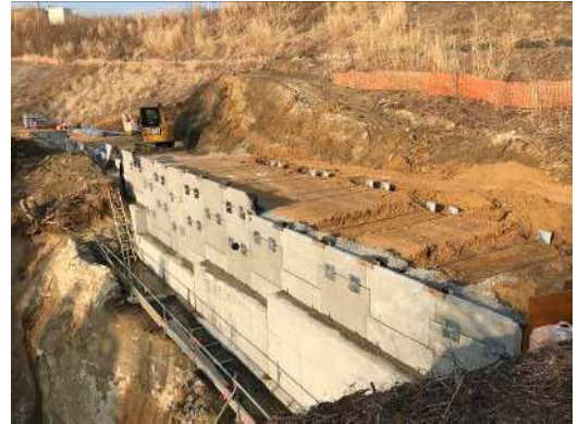
写真1 実験対象区間全景
