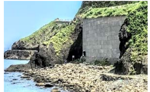
写真1 調査対象とした補強土壁
