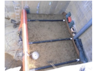
写真-2 排水パイプ設置 (ジオテキスタイル式)
