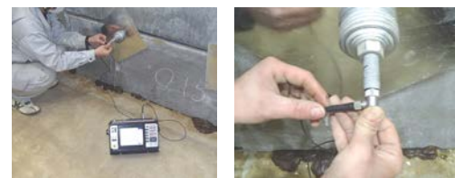
写真1 超音波探傷による測定状況 (左：全景，右：波動の入力)
