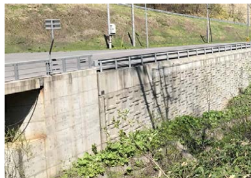
写真 1 調査対象の補強土壁
