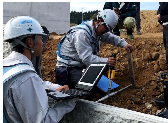
写真-2 実際の施工現場での計測の様子
