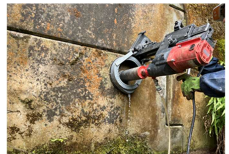
写真－1 横削孔時の様子
