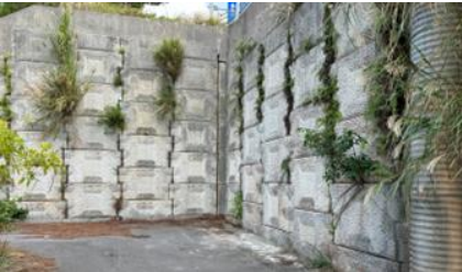
写真 1 対象補強土壁の外観(調査対象 C)
