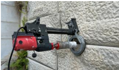
写真 2 横削孔時の様子
