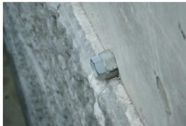
写真-5.7 キャップの取付け
