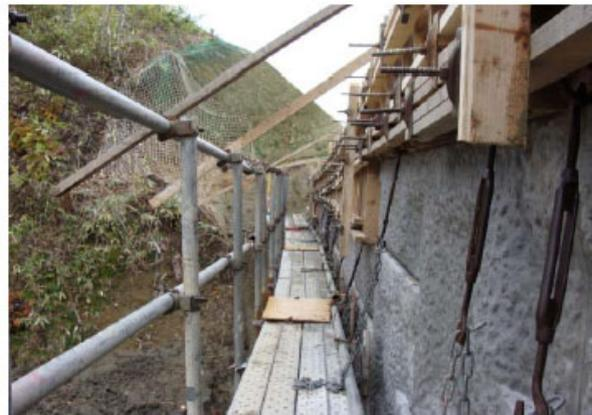
写真-5.5 型枠設置状況(足場側から)
