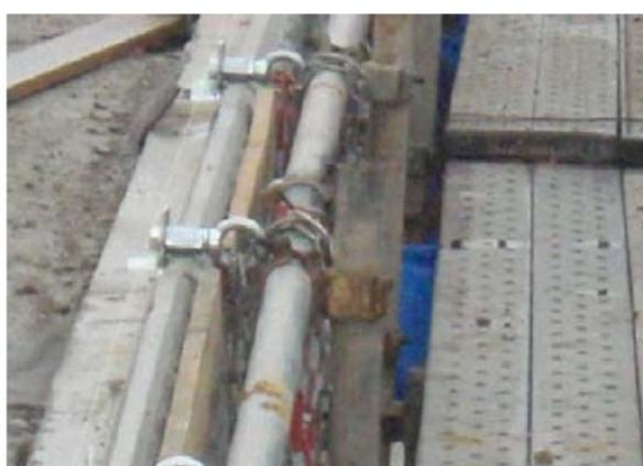
写真-5.2 単管、ブランケット、足場板の取付け
