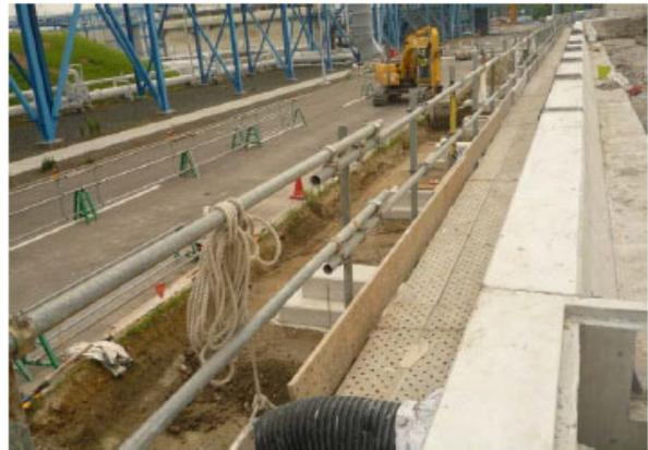
写真-5.6 笠コンクリート完成後(型枠脱型後)
