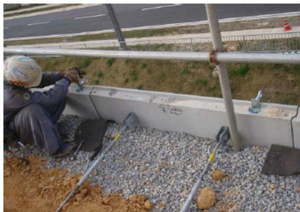
写真-5.1 吊り足場用金具(以下、金具)の取付け
