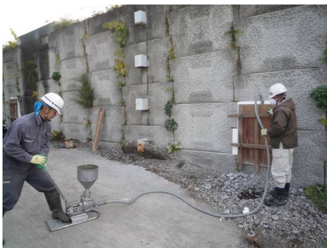
写真 5-6 グラウト打設状況（例）
