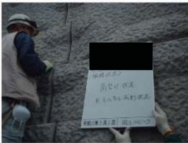
多数アンカー補修 角欠け Kモルタル成形
