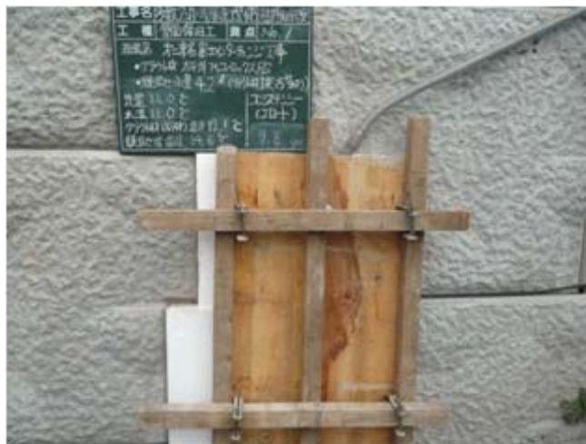
写真 5-5 型枠設置状況（例）
