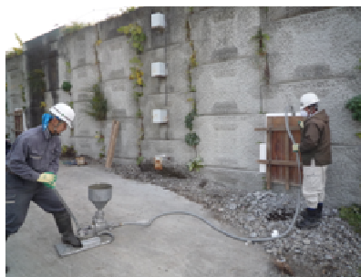
写真-5 グラウト打設状況
