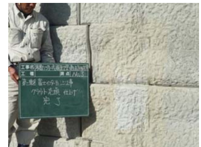
写真-6 復旧完了
