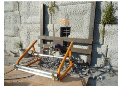
写真-3 反力装置 (H鋼)
