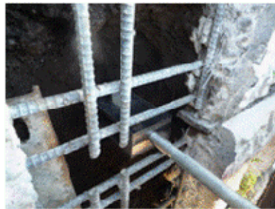
写真-2 テンションバー設置
