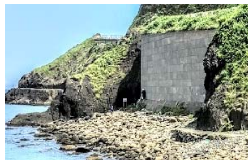
写真1 調査対象とした補強土壁
