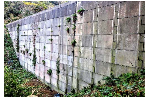
写真1 調査対象とした補強土壁
