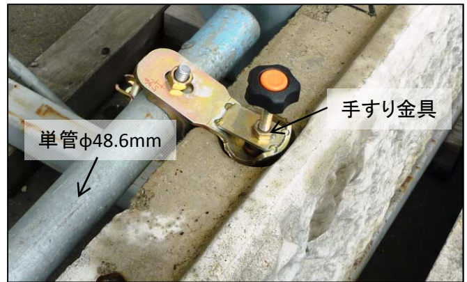
多数アンカー式補強土壁工法の転落防止措置の例
